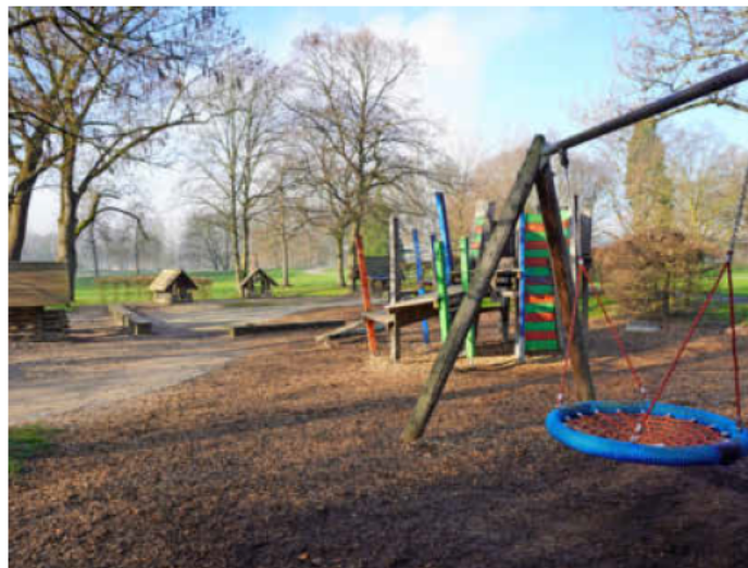
Der Spielplatz im Wertwiesenpark Nord wird seit dieser Woche saniert und auch neu gestaltet. Foto: Ühlin
