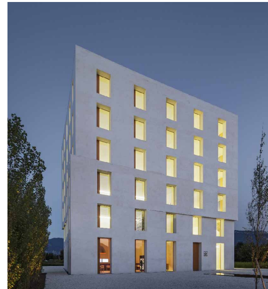
+ Homogener Massivbau ohne zusätzliche Dämmschicht Beispiel: Bürogebäude in Lustenau Architekt: be baumschlager eberle Foto: Eduard Hueber, archphoto
