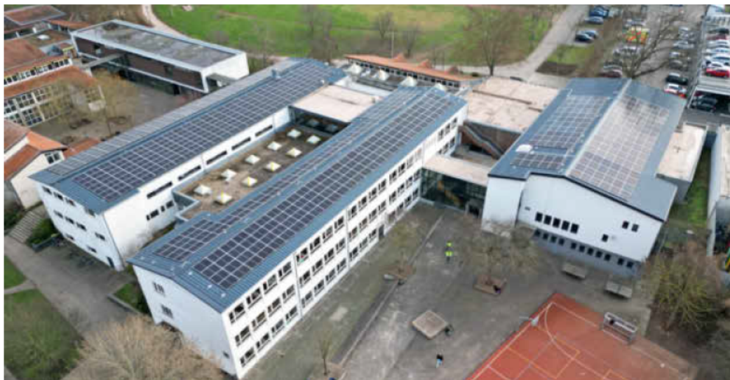
Ein weiteres Projekt auf dem Weg zur Treibhausgasneutralität: Auf dem Dach der Luise-Bronner-Realschule erzeugen Solarmodule künftig 240 000 Kilowattstunden Strom pro Jahr. Foto: Stadt
