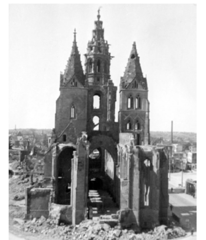
Blick auf die zerstörte Kilianskirche. Foto: Stadtarchiv Heilbronn
