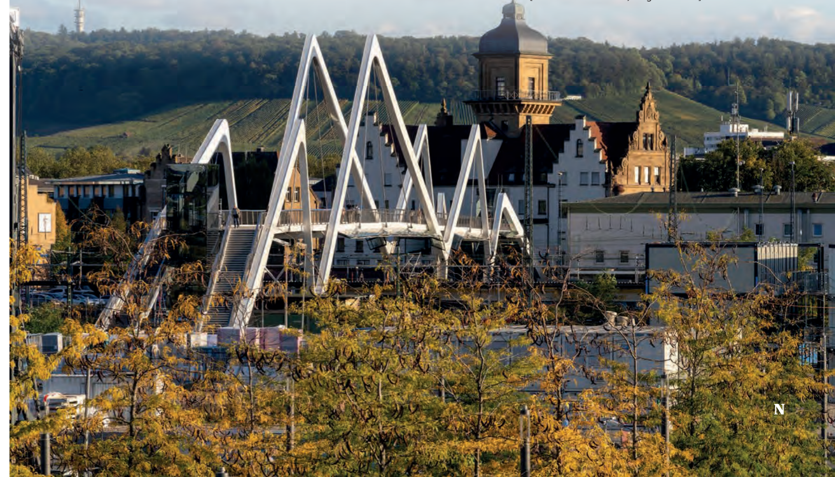
Zu Fuß oder mit dem Rad – über die neue BUGA-Brücke geht es nun noch schneller von der Bahnhofsvorstadt in den Neckarbogen. [Foto: Stadt Heilbronn; Jürgen Häffner]
