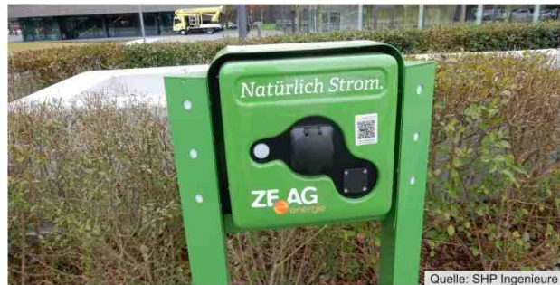
Quelle: SHP Ingenieure
