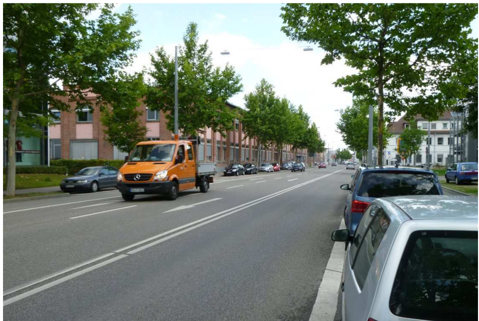
Abb. 15 Fehlende gesicherte Überquerungsmöglichkeit – Beispiel Weipertstraße
