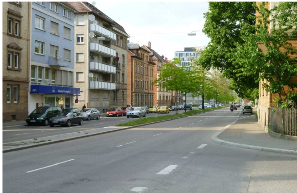
Abb. 13 Fehlende gesicherte Überquerungsmöglichkeit – Beispiel Oststraße
