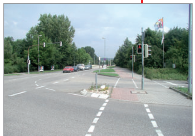
Radfahrfurt Brackheimer Straße
