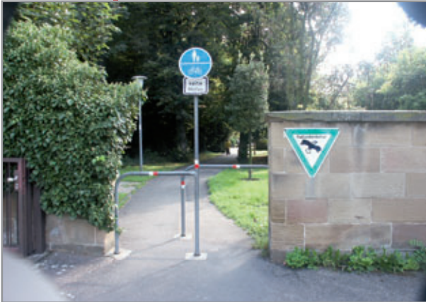
Abb. 15 Hindernis Umlaufsperr Alter Friedhof
